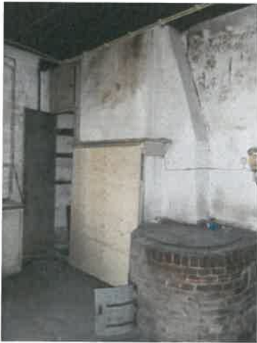
De keuken met de schouw en het gemetselde waterfornuis.
