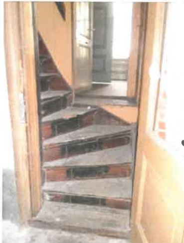
Opgang naar de zuidelijke opkamer met een trap naar de zolder die voorzien is van een geschilderde loper.
