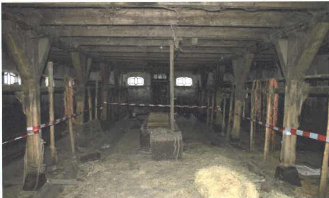
Het bedrijfsgedeelte van de Anthoniushoeve met de voerdeel in het midden en de stallen aan weerszijden. Goed te zien zijn de voederbakken en de koestaken waaraan het vee was vastgebonden.
