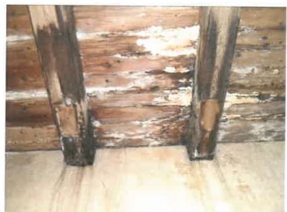
Twee hergebruikte balken met nog de sporen van de korbelen.
