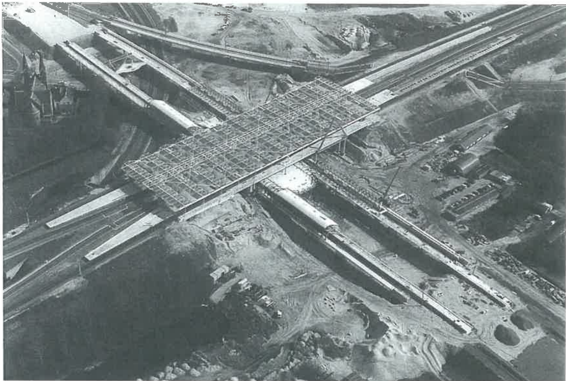
Station Duivendrecht tijdens de aanleg. Links boven de Sint Urbanuskerk. Bron: Bouwen in staal, maart/april 1993
