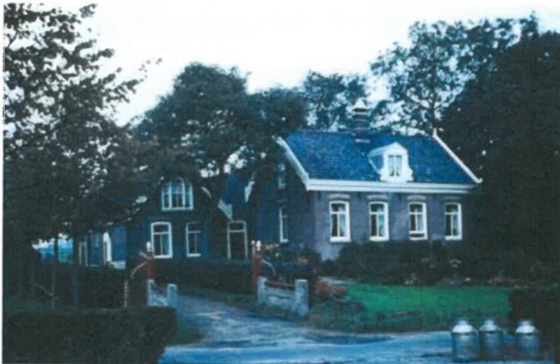
De opzet van een T-boerderij met een terugliggend zomerhuis met een topgevel, verbonden door een tussenlid is in de regio Amstelland een veelvoorkomend type. Hierboven de eveneens in Duivendrecht gelegen boerderij Zeldenrust een jaar voor de afbraak in 1967. De negentiende-eeuwse boerderij heeft een zelfde opzet als de Anthoniushoeve. Bron: Historische boerderijen in Duivendrecht
