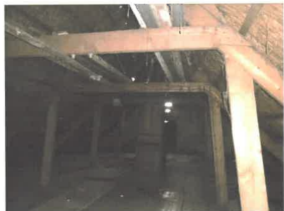
Hooizolder met A-spanten die voorzien zijn van standzonen.
