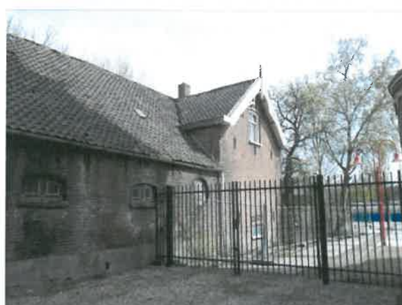
Zijgevel bedrijfsgebouwe en woonhuis.
